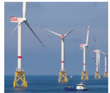
Aufwendig und kostenintensiv: Instandhaltung von Offshore-Windenergieanlagen. (Foto: Fotolia) | Laborious and expensive: maintaining offshore wind turbines. (Image: Fotolia)
