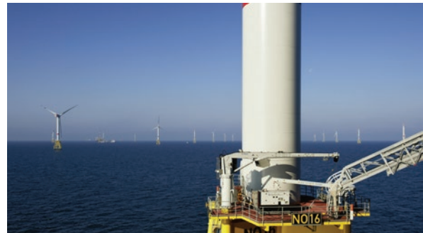
Installation und Wartung sind wesentliche Kostentreiber von OWEAs. (Foto: Servion) | Installation and maintenance costs are main drivers of high LCoE of offshore WECs. (Image: Servion)
